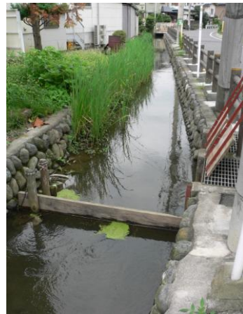
⑧日野は古くから用水路(ようすいろ)が作られ大切(たいせつ)にされてきた
