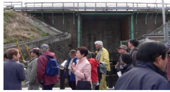
②日野レンガを使用したといわれる中央線日野駅傍の橋脚
