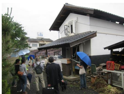
通風性を確保するために屋根との間に空間が設けられた蔵
