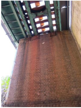
日野煉瓦の橋脚
