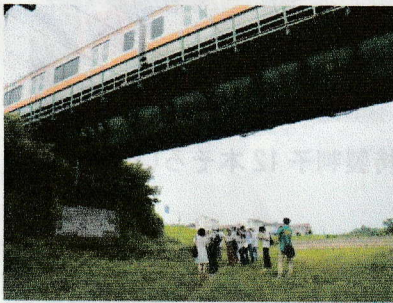
多摩川鉄橋を支える日野煉瓦
