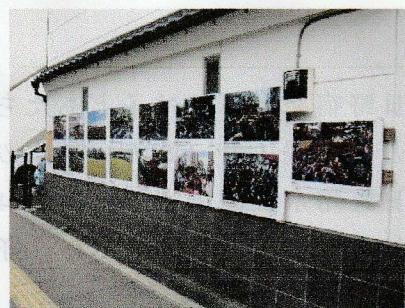
森町消防器具置場
