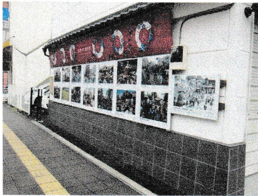
森町消防器具置場の壁面
