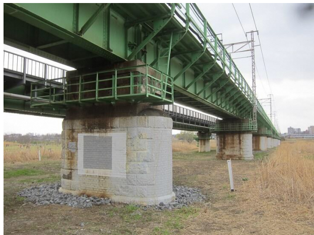
立川側多摩川鉄橋橋梁（日野煉瓦）
