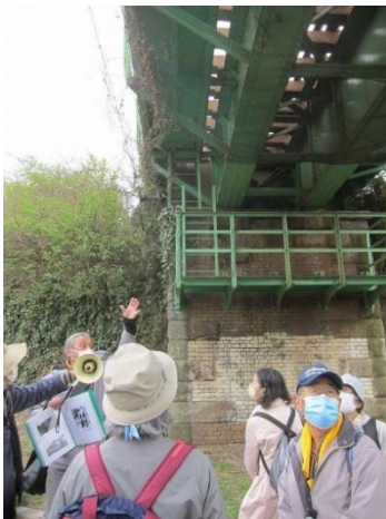
中央線多摩川橋築堤（日野煉瓦）
