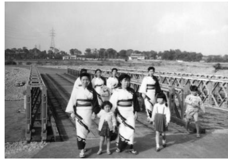
仮橋 昭和 39(1964)年 5 月 3 日
