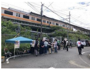
日野駅西日野煉瓦橋
