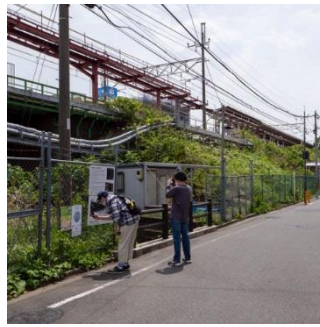
日野駅西煉瓦橋
