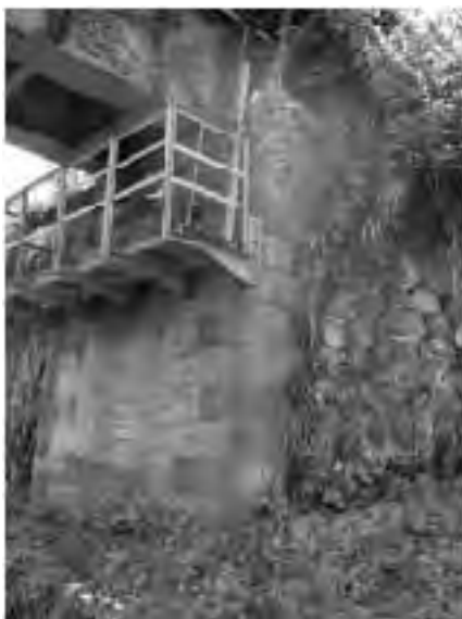
多摩川鉄橋上り線南詰め
